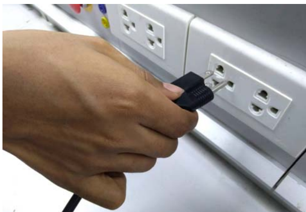
รูปที่ 1.7 แสดงเต้าเสียบเต้ารับชนิดมีขั้วสายดิน
